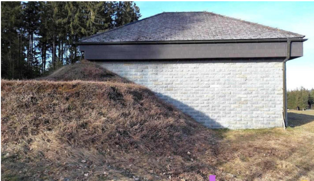
Wasserversorgungsanlage afiesl st stefan oberafiesl
