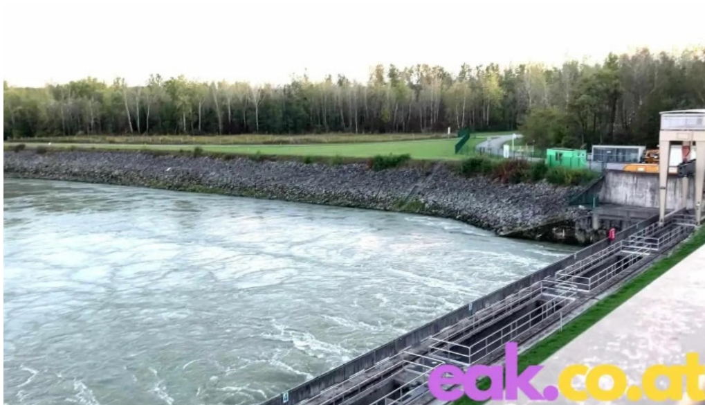
Verbund kraftwerk abwinden asten luftenberg an der donau
