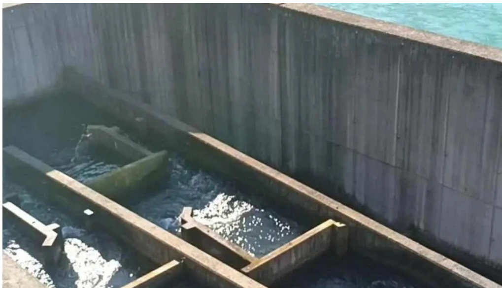
Verbund kraftwerk lavamund mit dem lavamunder torbogen videos
