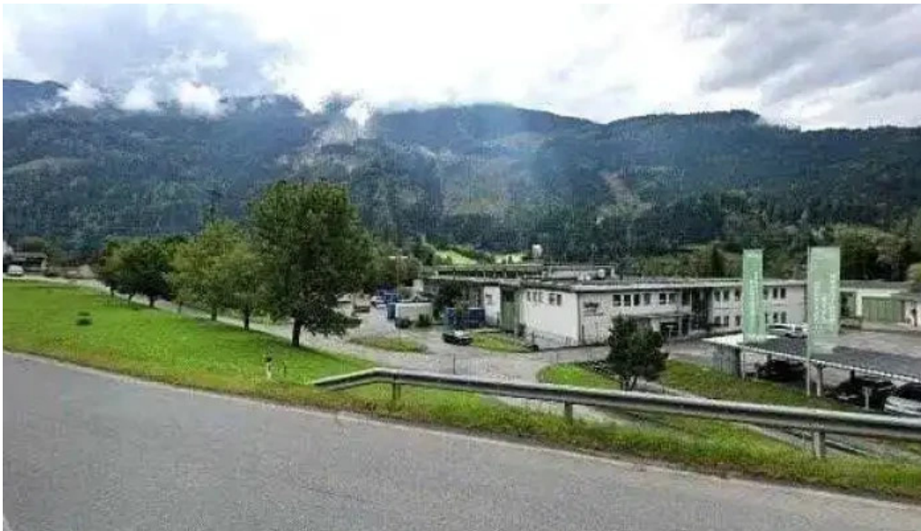
Kelag karntner elektrizitats ag kraftwerk ausserfragant alle
