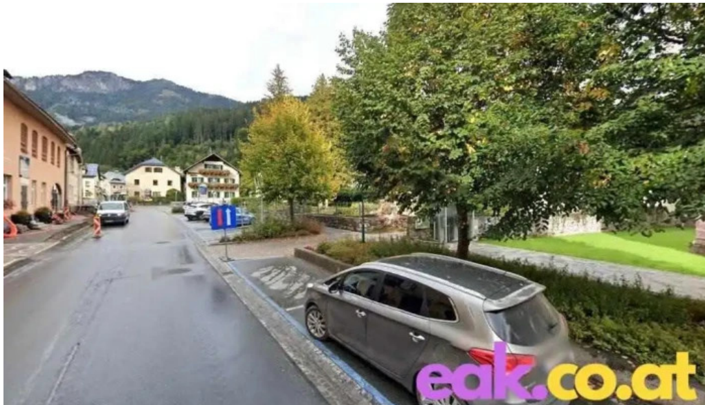
Aae wasserkraft kotschach mauthen
