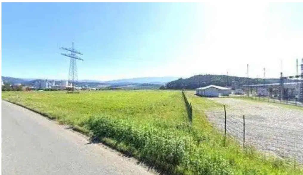
Umspannwerk treibach ii alle
