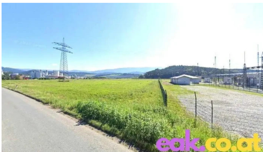
Umspannwerk treibach ii althofen
