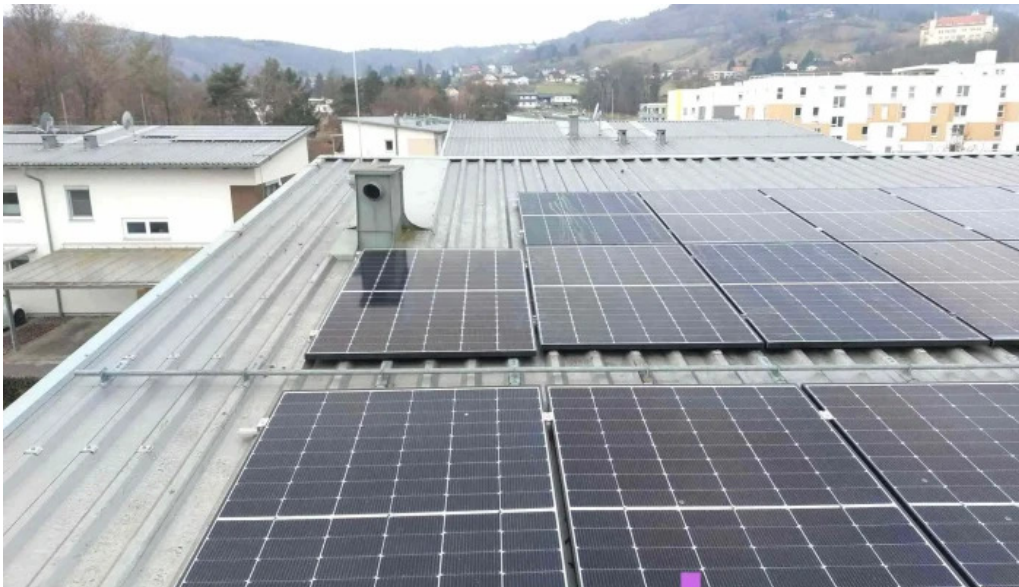
Enerix wolfsberg photovoltaik stromspeicher neueste
