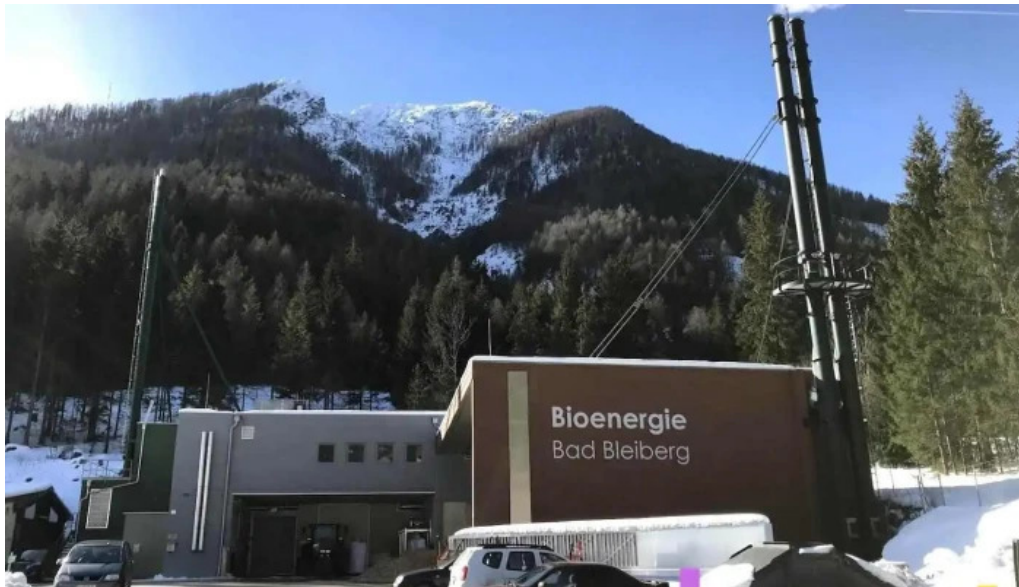
Bioenergie bad bleiberg
