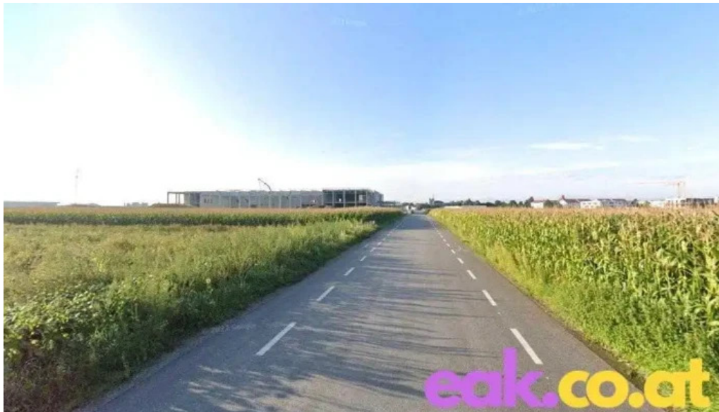
Fernheizwerk feldkirchen austria
