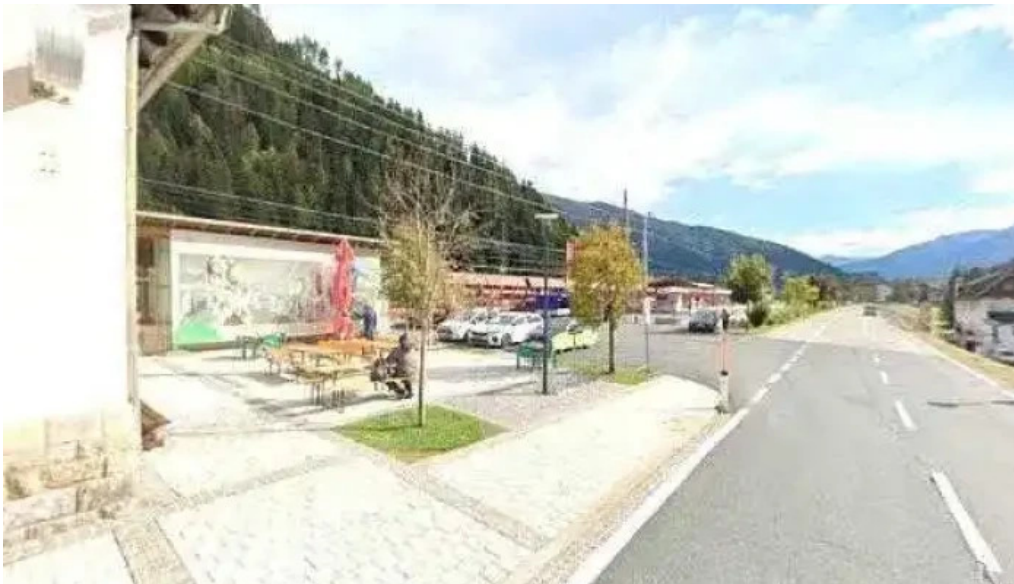
Stadtwerke klagenfurt ladestation alle
