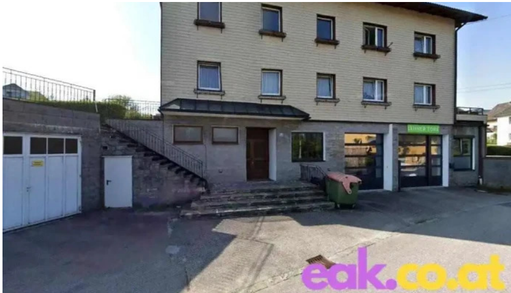
Oamtc charging station lembach im mühlkreis
