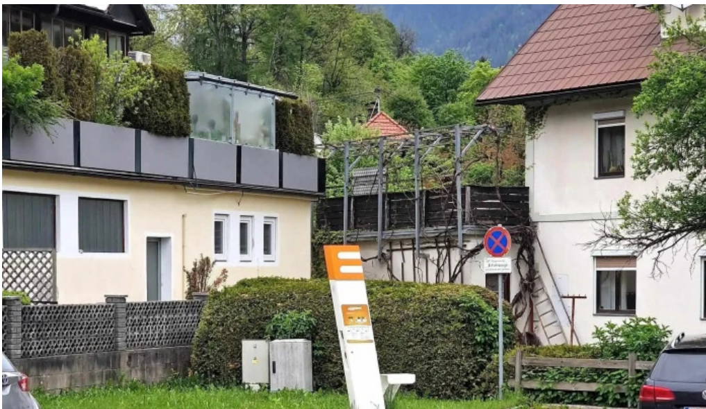
Stadtwerke klagenfurt ag ladestation ladestation fur elektrofahrzeuge
