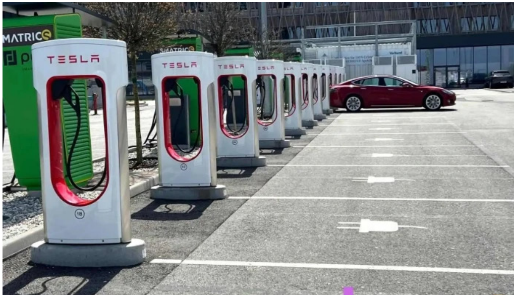
Ionity ladestation neueste
