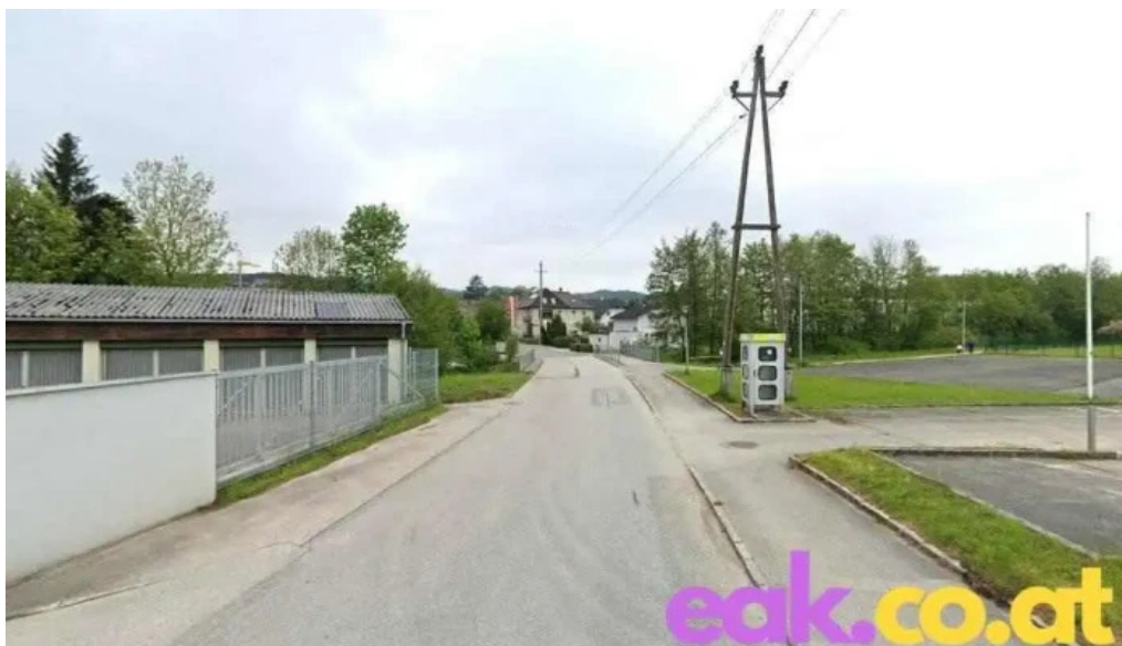
Energie ag charging station ampflwang im hausruckwald
