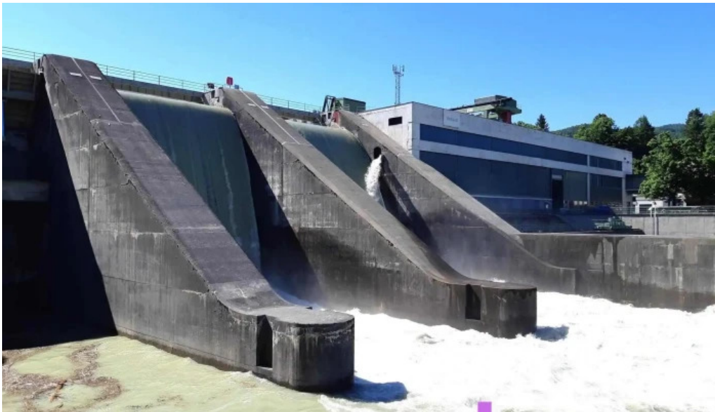
Laufkraftwerk feistritz im rosental alle
