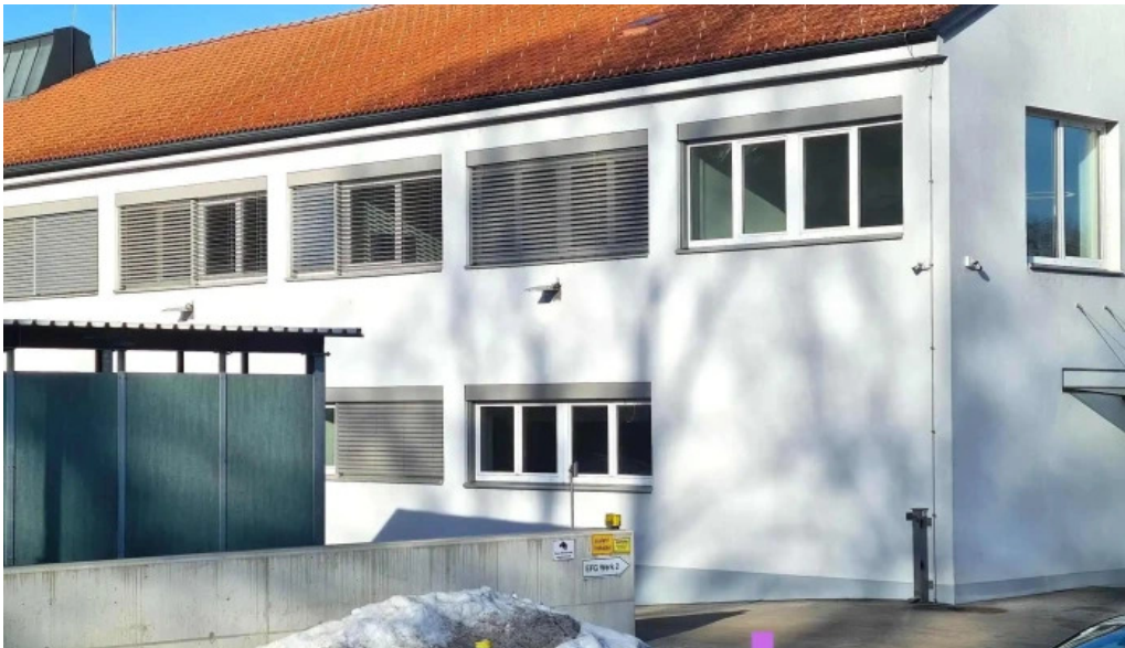
Efg turbinen und kraftwerksanlagenbau alle
