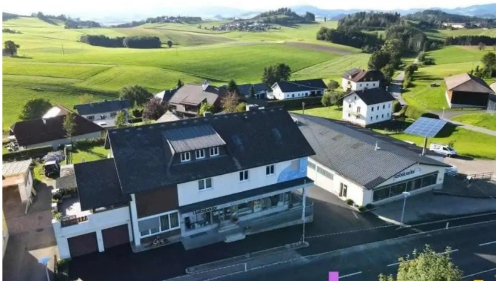
Leibetseder gas wasser heizung altenfelden
