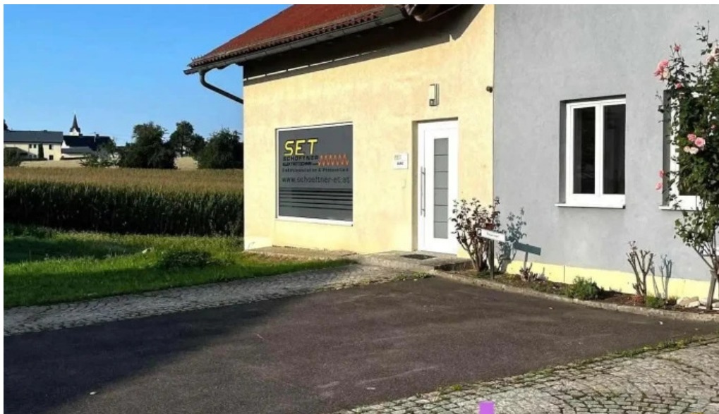
Set schoftner elektrotechnik gmbh herzogsdorf
