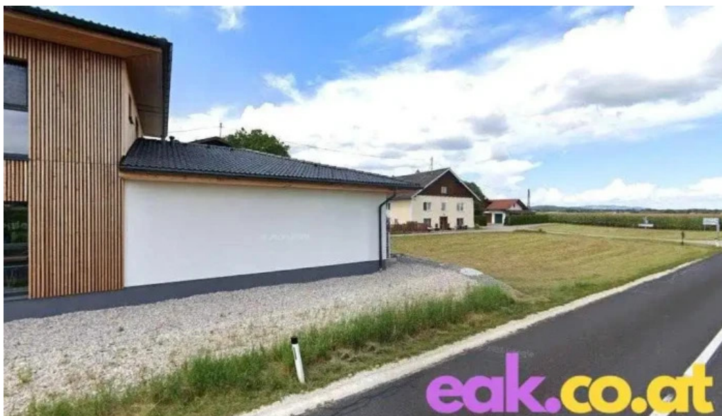
Juwe energietechnik desselbrunn
