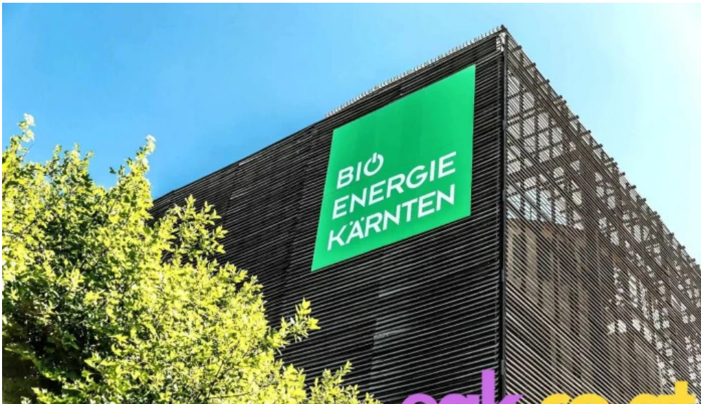
Bioenergiezentrum gmbh hkw sud vom inhaber
